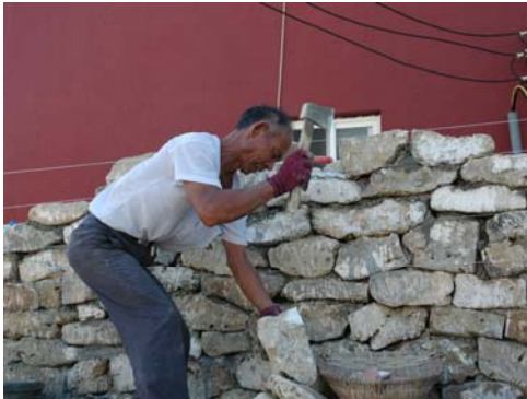
圖 7 削切白石以利疊砌及使得牆體表面平整
