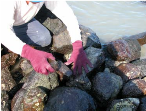
圖 17 以石頭當作敲擊工具，使石頭之間能更加緊密地相互嵌合在一起。
