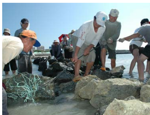
圖 20 拖運大型石材之粗繩網-「石擲仔」
