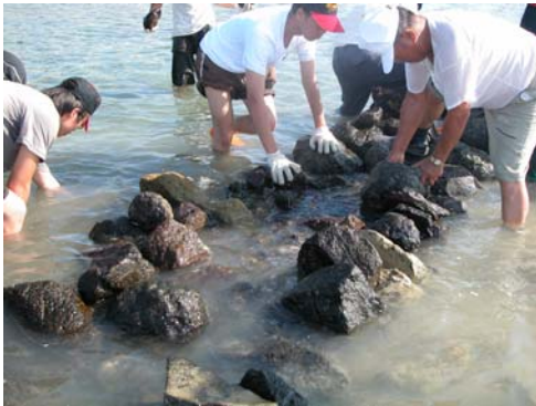
圖 15 石漚之構造形式以黑石為基礎，依靠石頭本身重量交互壓擠而穩固。
