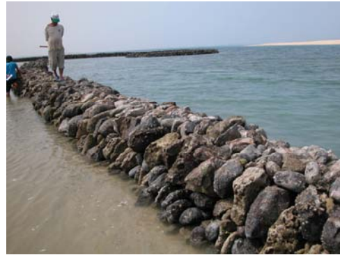
圖 18 伸腳寬度由底至頂逐漸內縮，至頂蓋面需略為收平以利巡漚行走。
