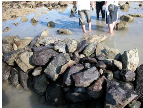
圖 16 黑石直立圍砌兩側後，中間之空隙得以各種石材填充，如此逐層上填。
