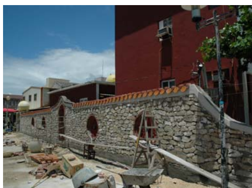
圖 1 於關帝廟前所進行之派出所圍牆砌築工程
