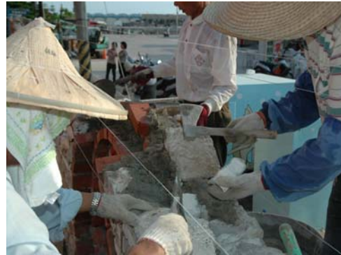
圖 8 利用斧頭背面敲擊石頭，以獲得小型石塊供牆體內部充填及墊固大石。
